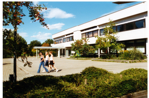
Erich-Kästner-Hauptschule, 1998. Einst als 2. Bauabschnitt des OHG geplant, diente das Gebäude in den Anlagen jahrzehntlang als Hauptschule. Für die Gemeinschaftsschule ist es zu klein. Nach dem Abriss der Sporthalle I wird die Raumnot behoben.
